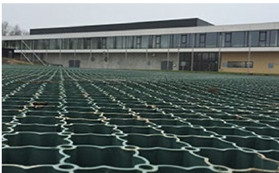
Græsarmeringen inden påfyldning af grus.
