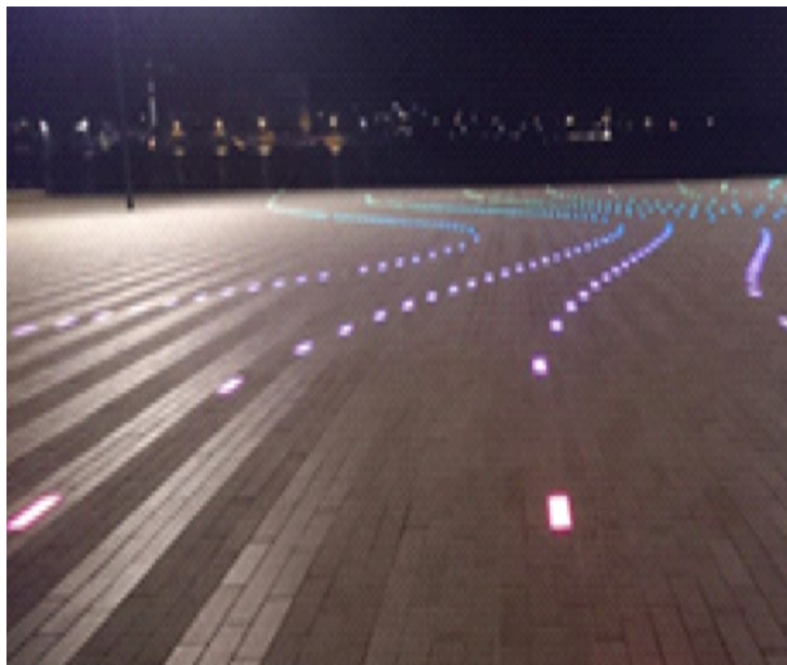
Multiline linjedræn med LED lys sikre afvanding af forplads og facader
