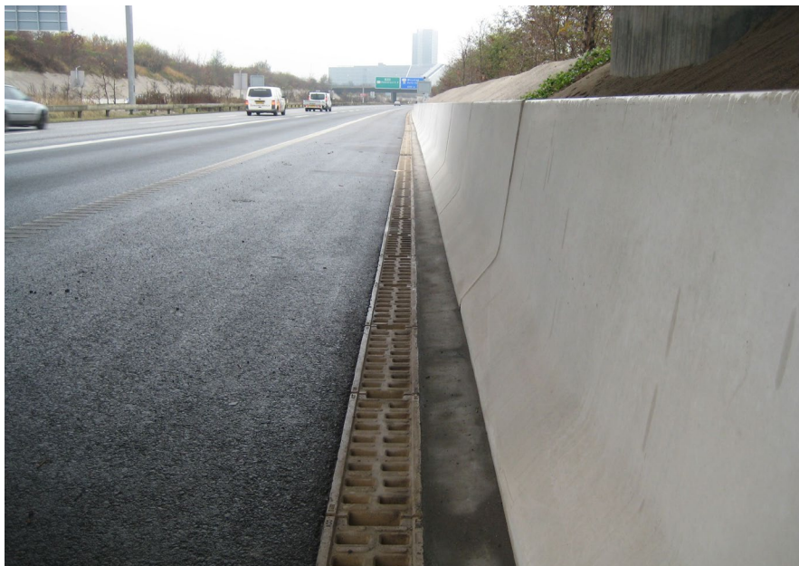
ACO MONOBLOCK 200 er kendetegnet ved sin monolitiske udformning, der gør den yderst trafik-sikker.
