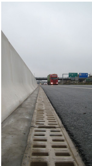
ARKIL A/S - ANLÆG fik til opgave at installere afvandingsrenderne.
