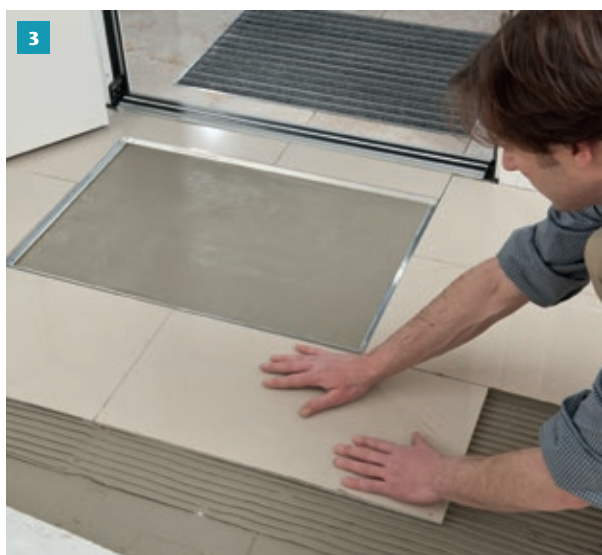
3 Tilstødende overfladebelægning lægges. Efterlad en lille ekspansionsspalte mellem belægning og ramme.
