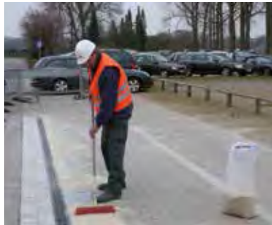
8. Flisefuger efterfyldes med fugesand.
