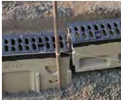
5. Placer liniedræn så fed og not går i indgab. Benyt muresnor for at sikre vandret installation.
