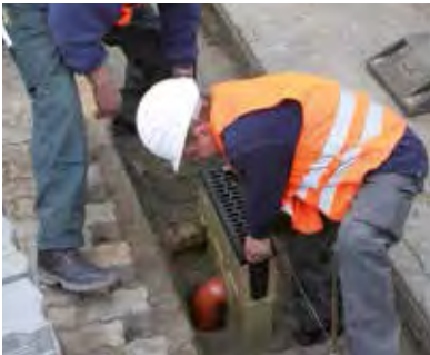
4. Tilslut kloak til liniedrænets udløb.
