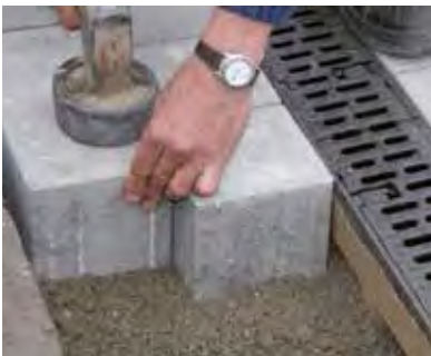
7. Randsten monteres afslutningsvis.
