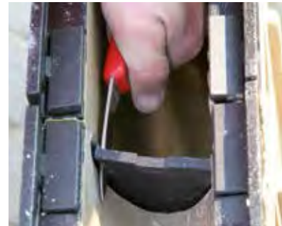
6. Gummivæg i bladfang bortskæres svarende til indvendig profil i liniedrænet.
