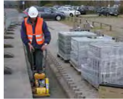
3. Udlæg og komprimer beton fundament.
