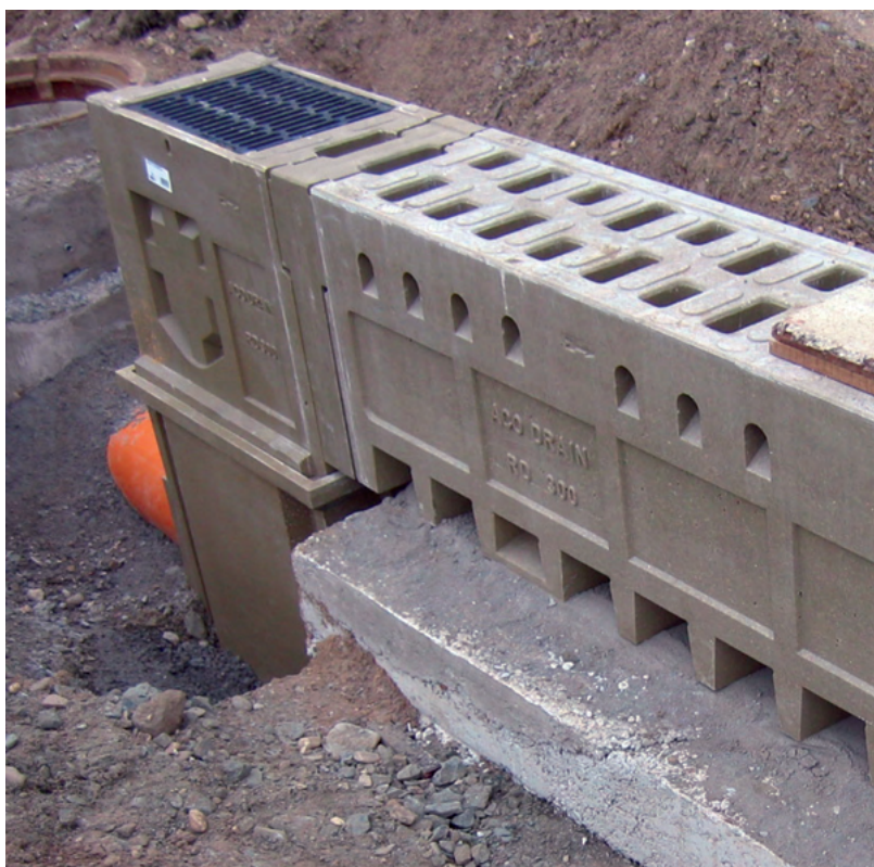
ACO DRAIN® Monoblock RD 300 ved motorvej A3 - Köln i Tyskland.
